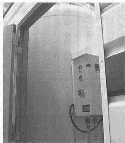
LPG特定供給設備(外観④、バルク貯槽⑤)
